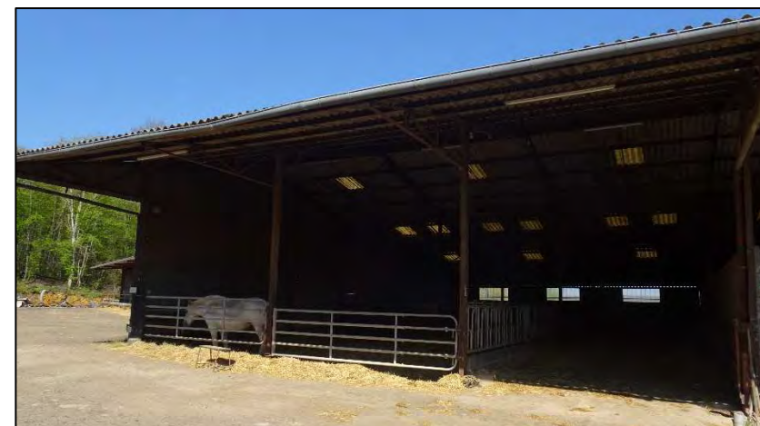
Photographie 11 : Bâtiment pouvant accueillir les taureaux (à gauche) (source : ENCIS Environnement)
