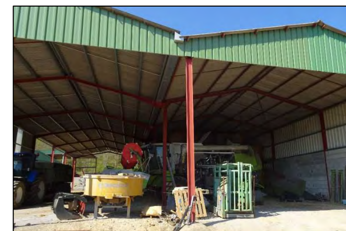
Photographie 14 : Hangar utilisé pour le stockage du matériel, situé au centre de la ferme (source : ENCIS Environnement)
