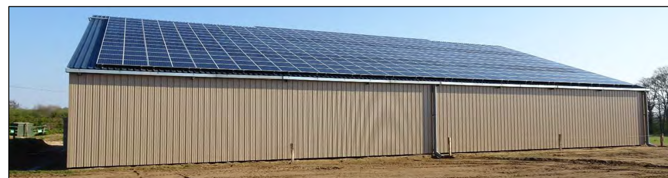
Photographie 2 : Hangar agricole de stabulation équipé de panneaux photovoltaïques sur la parcelle C 286 (Source : ENCIS Environnement)
