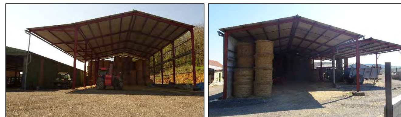
Photographie 5 : Hangars de stockage de paille et de foin (source : ENCIS Environnement)
