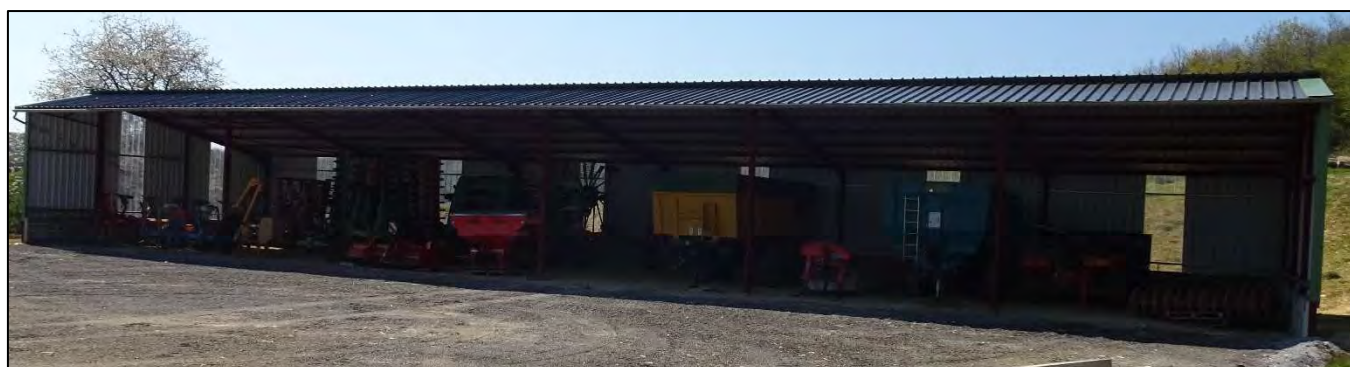
Photographie 15 : Hangar récent utilisé pour le stockage du matériel, situé au sud de la ferme (source : ENCIS Environnement)
